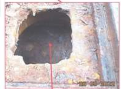
จุดเก็บตัวอย่างน้ำเสียจากระบบบำบัด มีกากและตะกอนหนาแน่น
