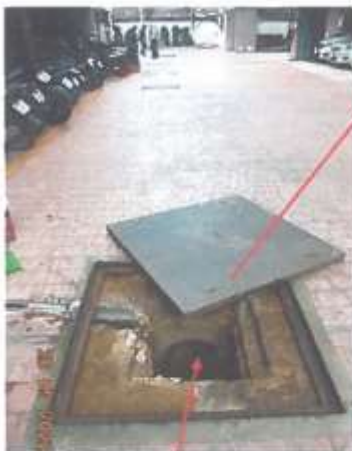
1. ระบบบำบัดน้ำเสีย แอมะงจากท้ายไม่ไหลบ่อ (ในภาพคือบ่อเกรอะ หรือบ่อเก็บกาก)
