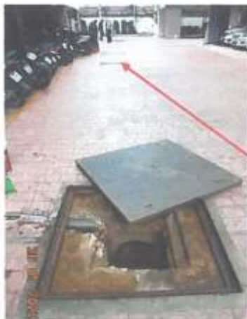
4. สภาพท่อระบายน้ำ ที่ออกจากระบบบำบัด (ฝาท่ออยู่หน้าจุดเก็บน้ำทิ้ง) สังเกตว่ามีเศษตะกอนสะสมในเส้นท่อน้ำมาก และน้ำไหลออกตะกอนในเส้นท่อน้ำอย่างน้อยปีละ 1 ครั้ง ควรลอกเลนตลอดแนวท่อระบายน้ำทิ้ง จนถึงบ่อหมักน้ำทิ้งโครงการ รวมทั้งให้ตรวจสอบว่ามีน้ำเสียจากส่วนอื่นไหลลงท่อระบายน้ำทิ้ง โดยไม่ผ่านระบบบำบัดหรือไม่
