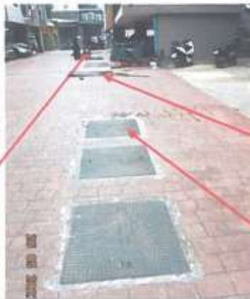
1. ระบบบำบัดน้ำเสีย แอมะงจากท้ายไม่ไหลบ่อ (ในภาพคือบ่อเกรอะ หรือบ่อเก็บกาก)
