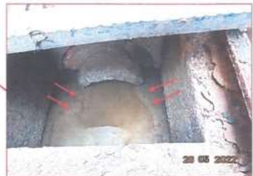
4. สภาพท่อระบายน้ำ ที่ออกจากระบบบำบัด (ฝาท่ออยู่หน้าจุดเก็บน้ำทิ้ง) สังเกตว่ามีเศษตะกอนสะสมในเส้นท่อน้ำมาก และน้ำไหลออกตะกอนในเส้นท่อน้ำอย่างน้อยปีละ 1 ครั้ง ควรลอกเลนตลอดแนวท่อระบายน้ำทิ้ง จนถึงบ่อหมักน้ำทิ้งโครงการ รวมทั้งให้ตรวจสอบว่ามีน้ำเสียจากส่วนอื่นไหลลงท่อระบายน้ำทิ้ง โดยไม่ผ่านระบบบำบัดหรือไม่
